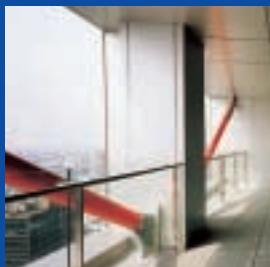
制震ダンパーをデザイン要素としても活用 構造計画研究所 本所新館（東京都中野区・自社設計）
