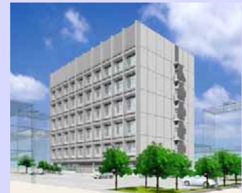
京葉ガス新監視指令センター
