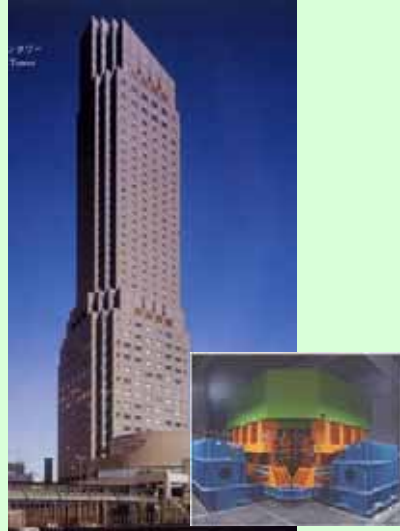
セルリアンタワー東急ホテル
