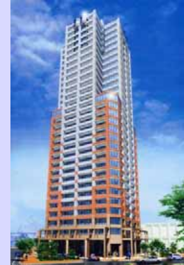
福岡県内集合住宅
