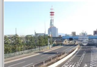
青森県で震度6強を観測した地震で損傷が確認されたNTT青森八戸ビルの鉄塔。手前は一部通行止めとなった国道45号=20日午後、青森県八戸市
