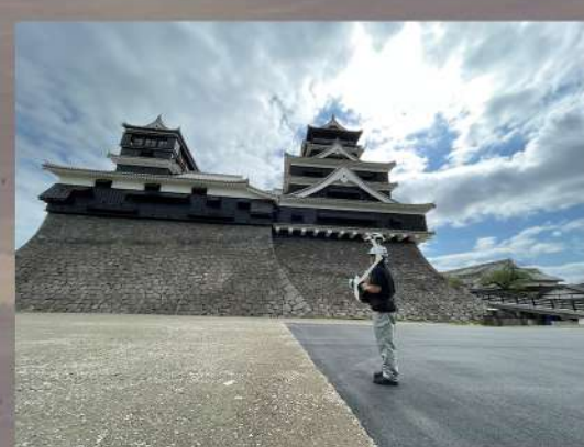
熊本城天守閣復旧(2021年3月)
